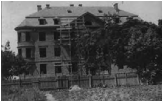
Станіславів, вул. Камінського / Франка. Клініка Яна Гутта під час будівництва
